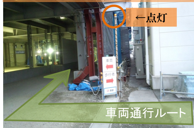
搬入路設置ランプ
