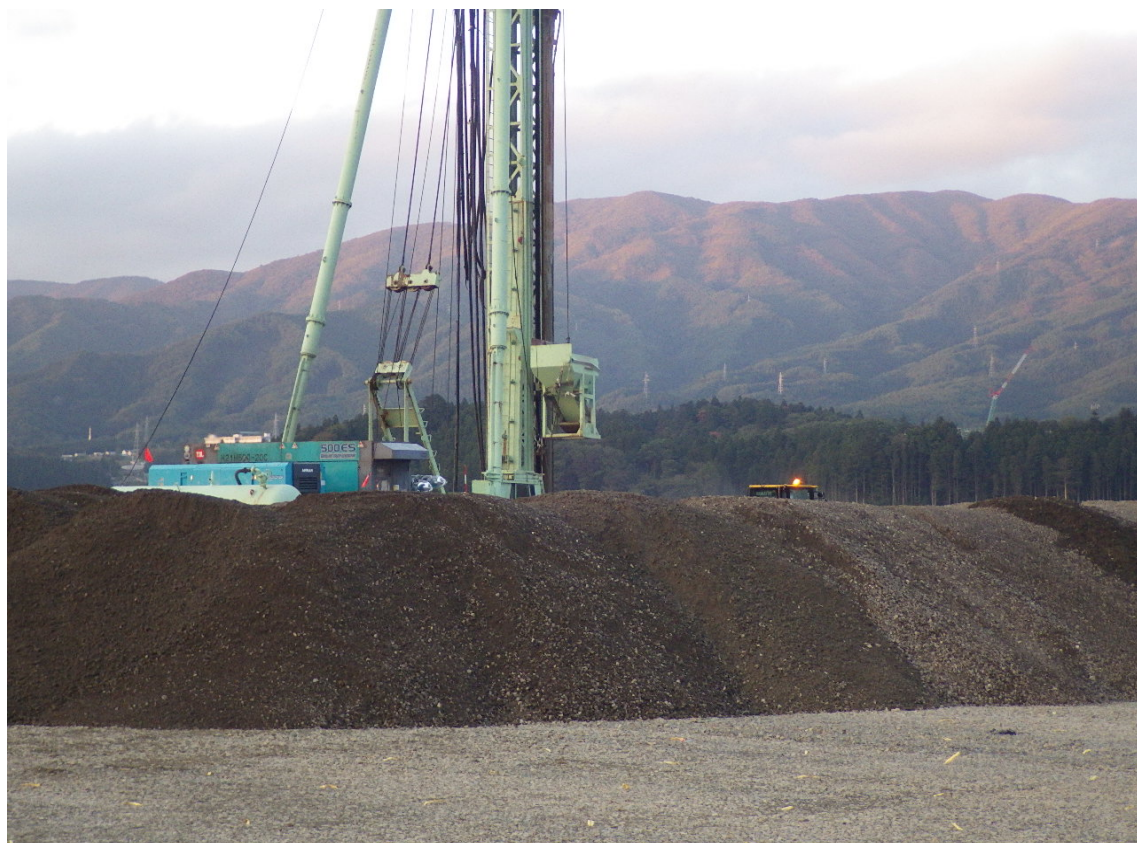
写真-2 タイヤショベルローダーのパトライト視認状況 (碎石の高さを2.5m以下に抑えて、常にパトライトが見えるようにルール化している)
