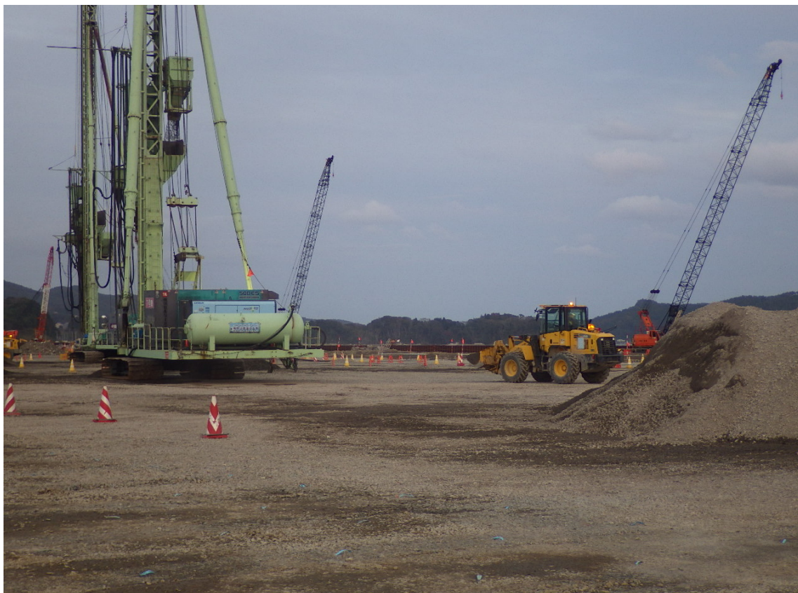
写真-1 タイヤショベルローダー稼働状況
