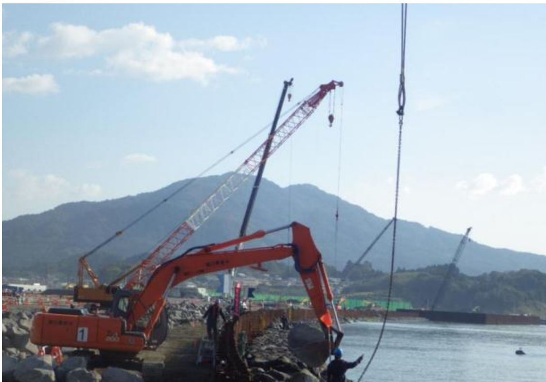
写真-1 バックホウミラーによる作業状況
