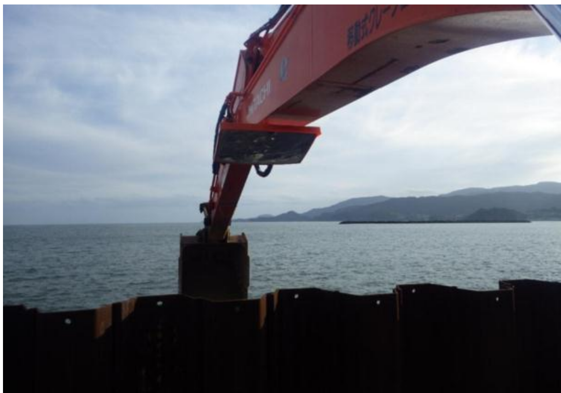
写真-2 バックホウミラー取付け状況
