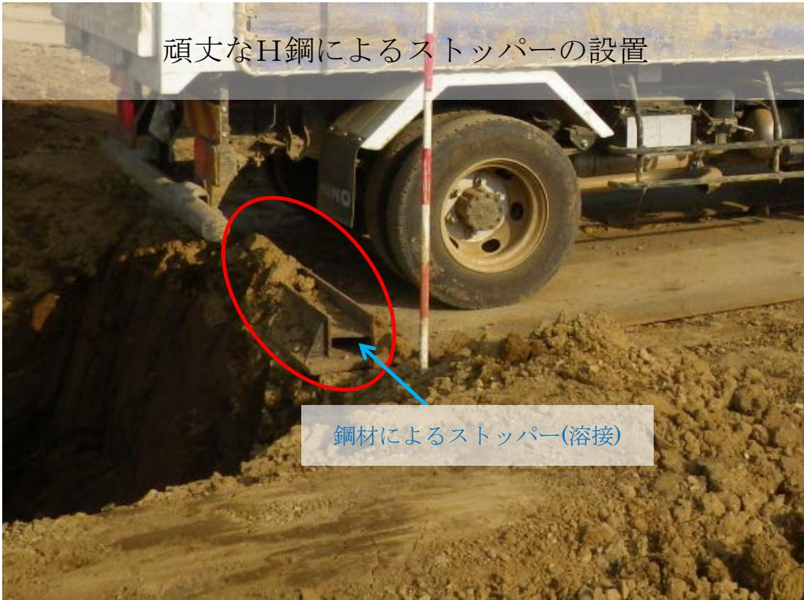
鋼材によるストッパー(溶接)
