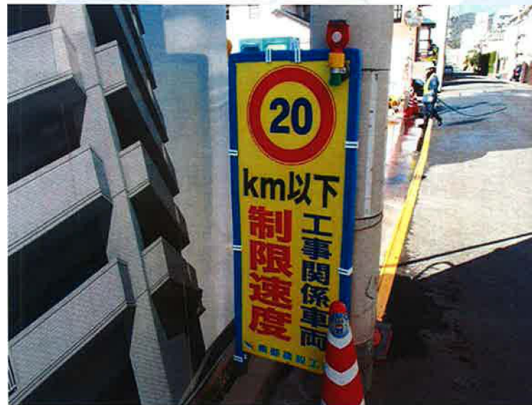
工事車両に制限速度を一目で分かるように表示しています。
