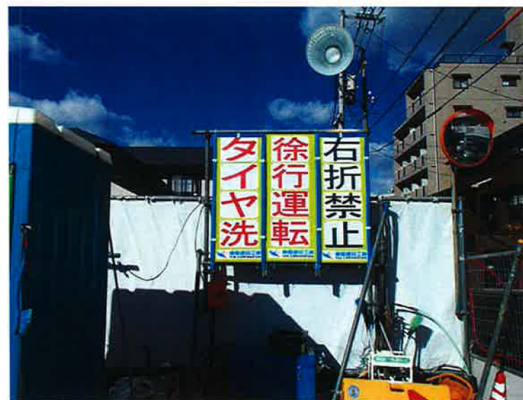
工事車両に一目で分かるように作業所ルールを掲示しています。
