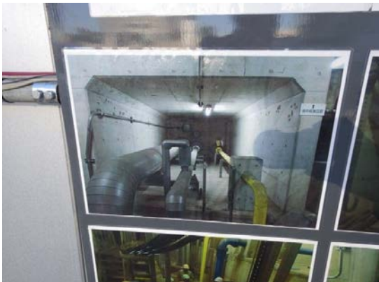
拡大写真-1 この突き当りが当現場 地下6m付近
