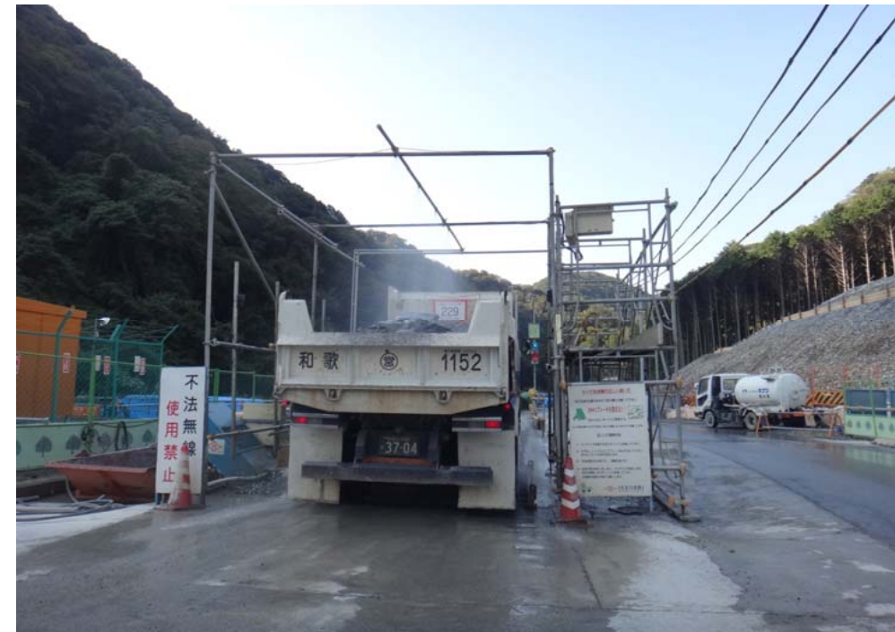
過積載防止センサーによる計測状況
