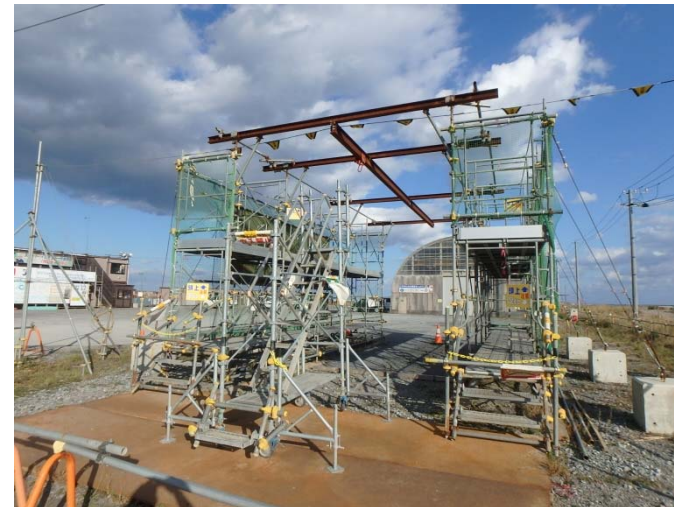
写真② シート外し架台全景（後方）
