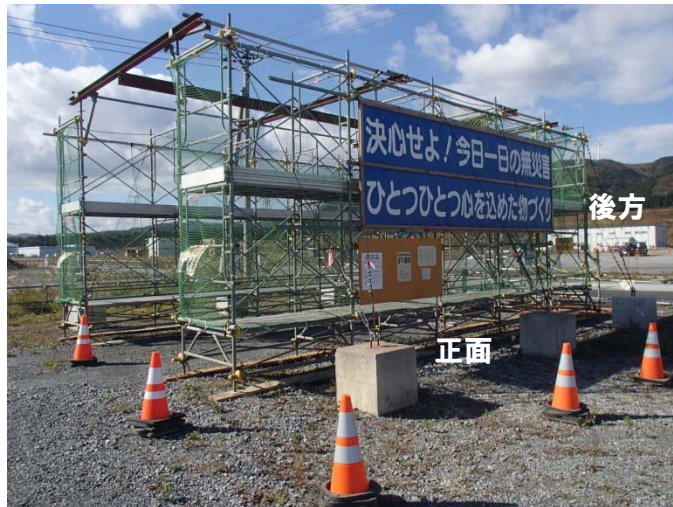
写真① シート外し架台全景（正面）
