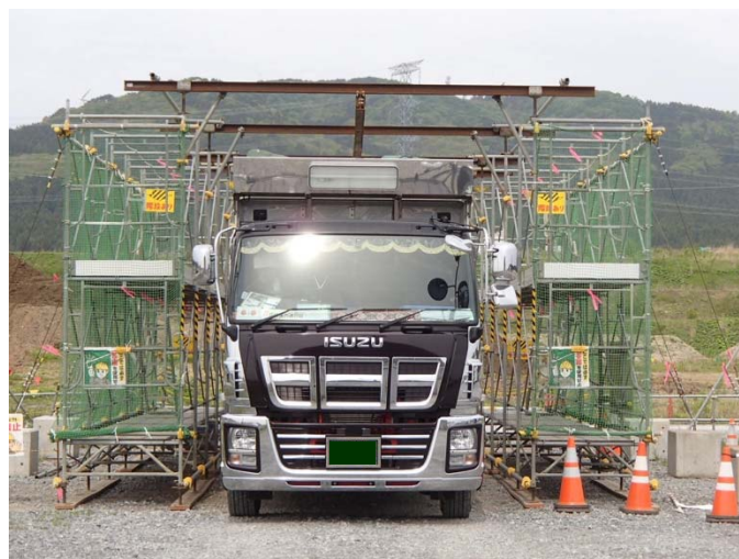
写真③ シート外し架台トラック停車状況
