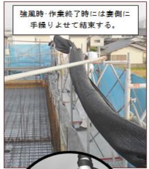
シート周囲を補強ロープを通した幅5400の特注シートを作成し三方を足場に結束する。親綱と緊張機を使って十文字に張りシートのたわみを低減させる。
