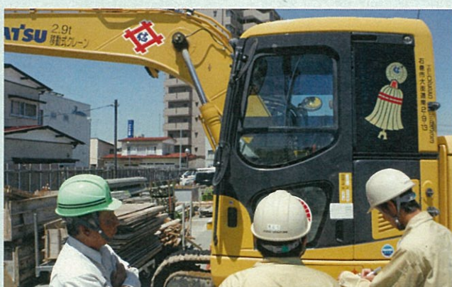
重機機械の点検
