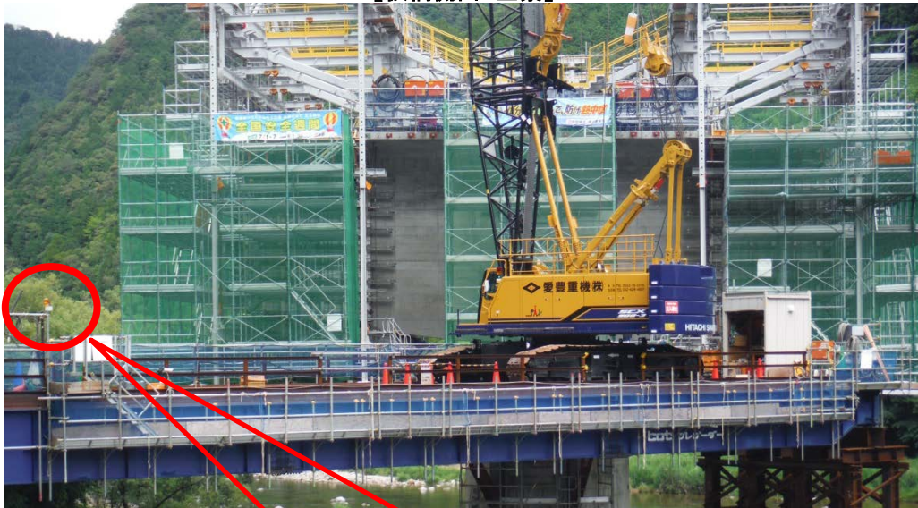
【仮橋側面 全景】
