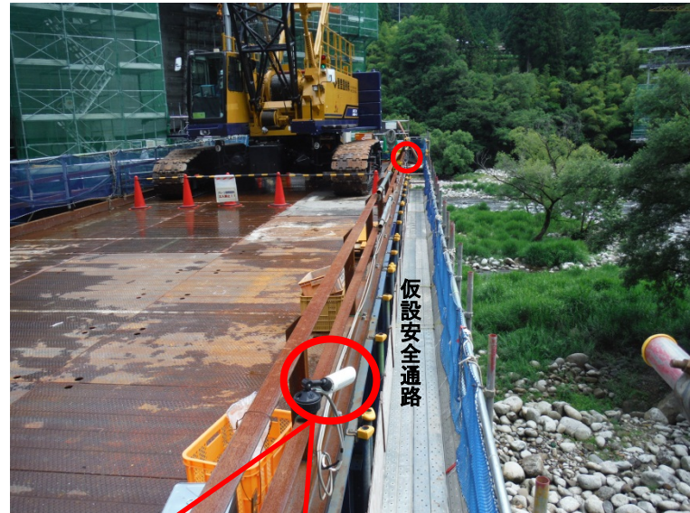
【仮設安全通路 全景】
