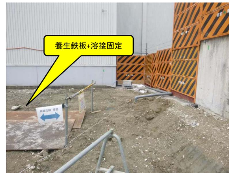
高圧線直上に敷き鉄板+溶接固定（杭工事用）
