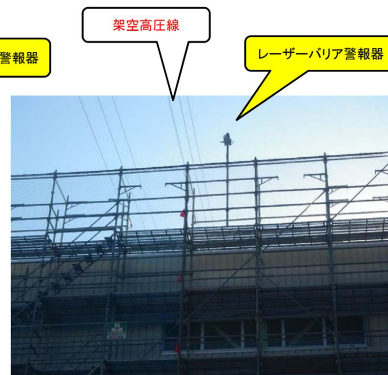
レーザーバリアによる警戒（垂直方向）屋根工事時
