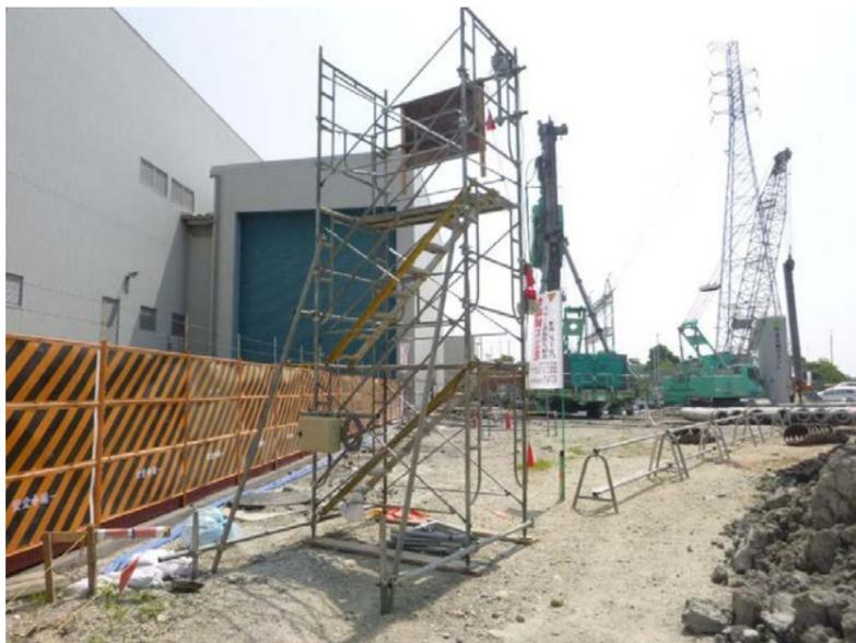
レーザーバリアによる警戒（垂直方向）杭打ち時
