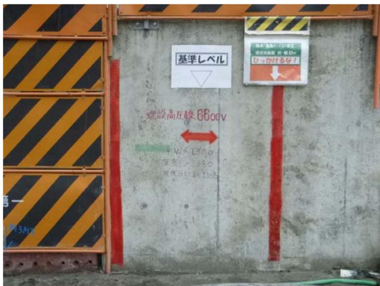
高圧埋設配管位置明示（東側端部）
