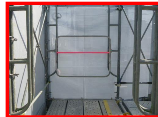
足場の色付きエンド手摺
