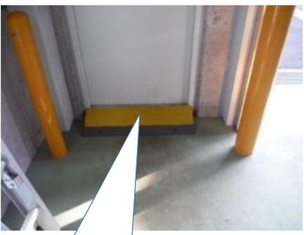
・スロープを設置し、アンカーボルトで固定
