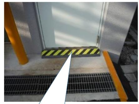
・スロープを設置し、アンカーボルトで固定
