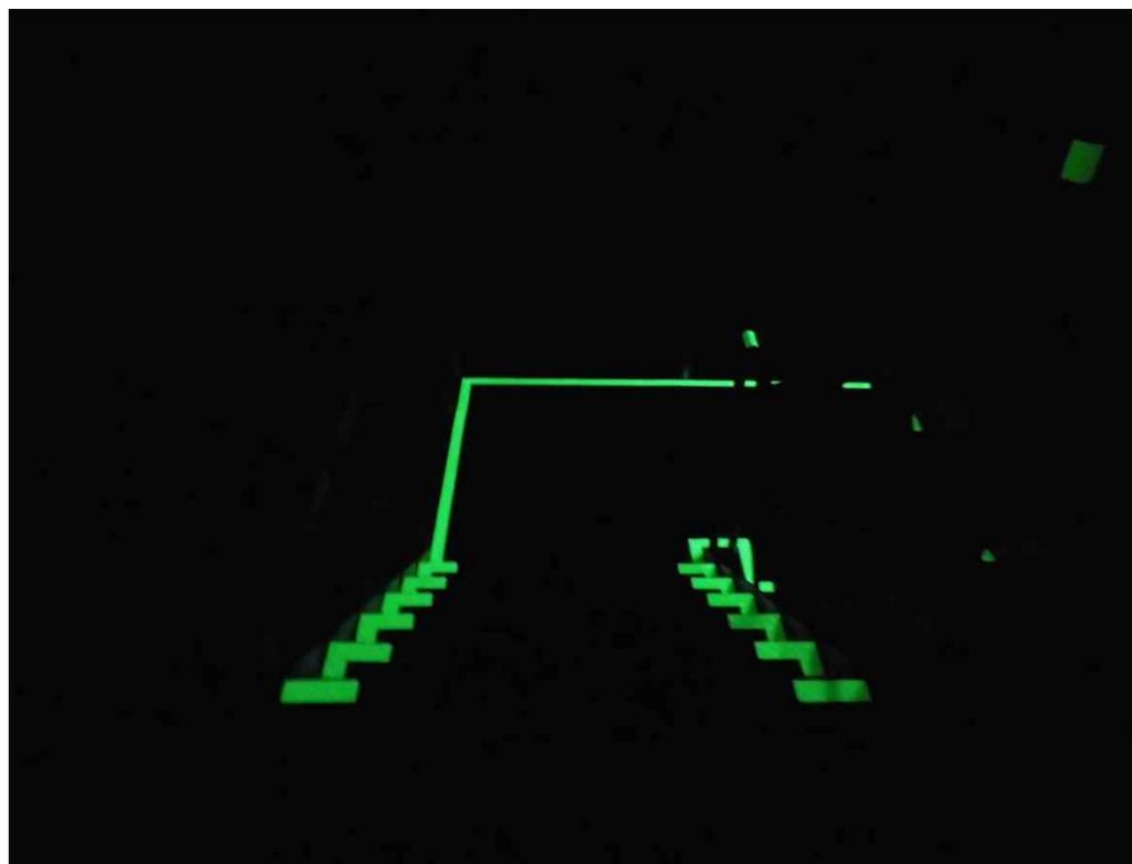
2階倉庫の出入口前の階段は、移動を開始して音感知式照明が点くまで時間差があったり、移動途中で照明が消えることがあります。不意に視界が暗くなることで階段を踏み外して、転倒する恐れがありますので、階段の両端・踊り場淵に蓄光テープを貼りました。
