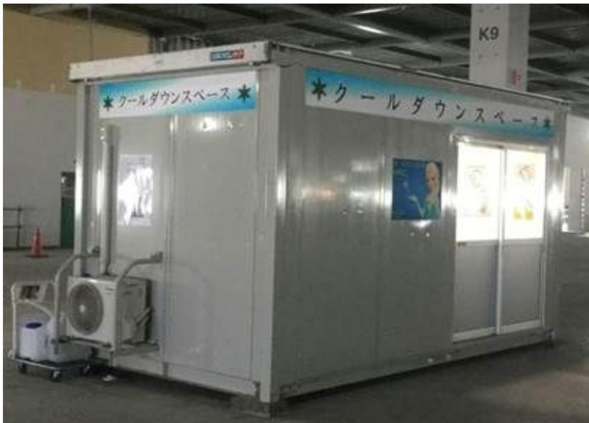
作業所内の各フロアにユニットハウスを設置し「クールダウンスペース」として常時空調、熱中症発症時の応急処置場所として使用する。常時は、作業員のための涼しい休憩場所として使用し、体温冷却効果と、塩分補給用の飴の常備により、熱中症の予防に役立っている。
