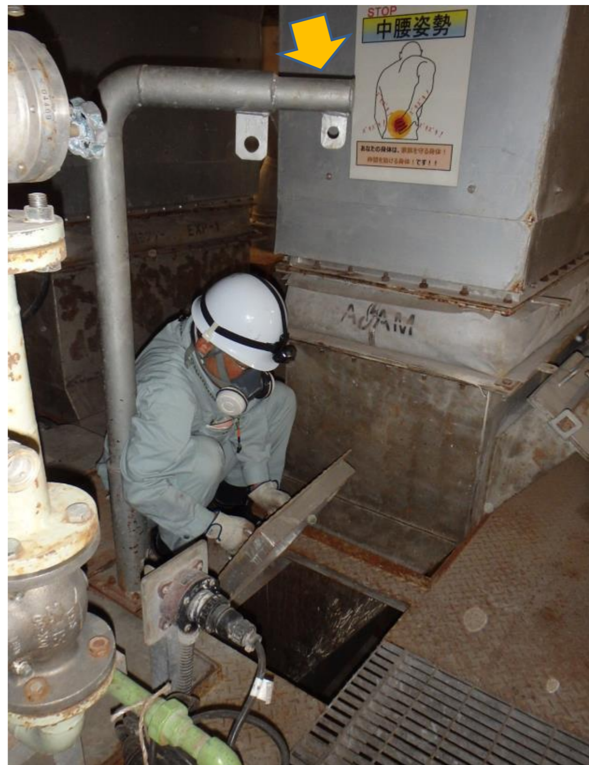
吊りフック延長部
