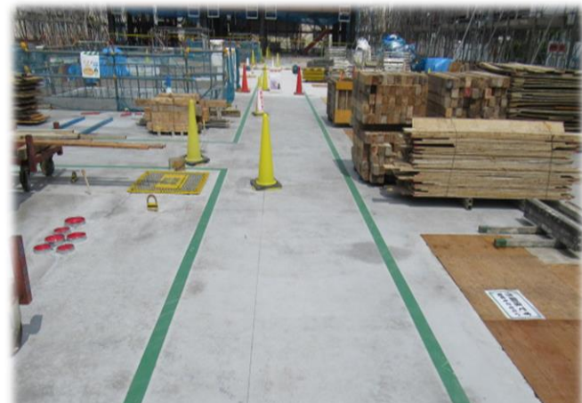
建物内 安全通路
