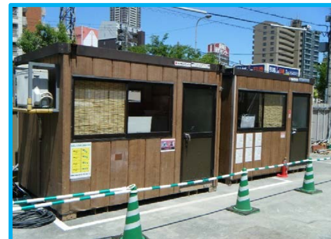
作業エリアにエアコン付き休憩スペース完備
