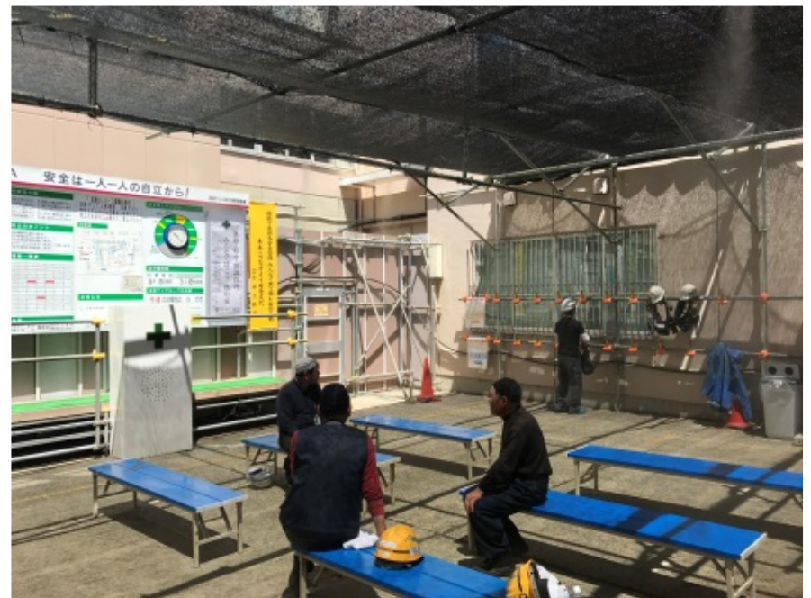
朝礼終了後は憩いの場に改良 屋根は農業ネット 上部に噴霧器を配置
