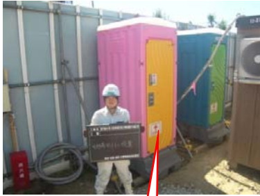
フラワートイレの設置
