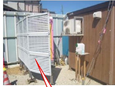
ルーバーフェンスの設置
