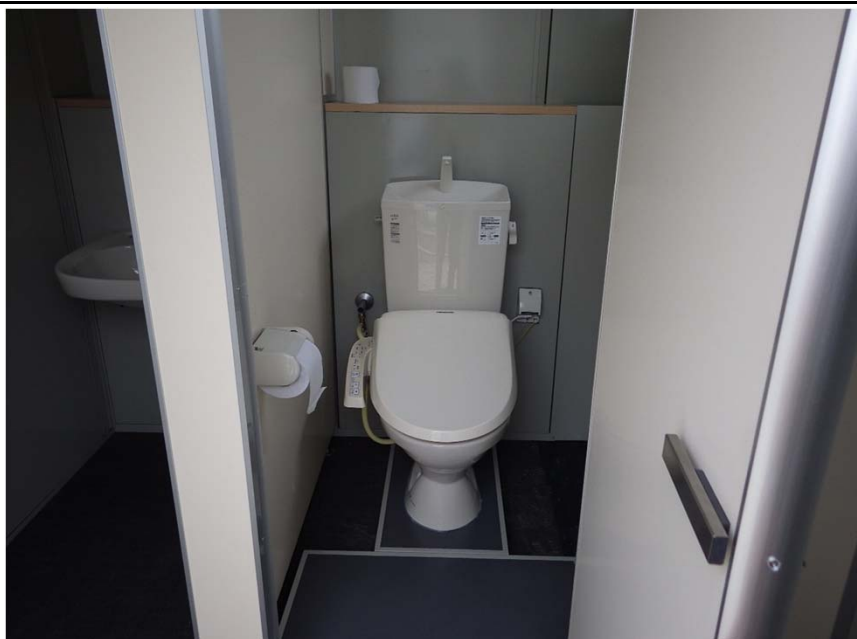
女性用トイレ内部
