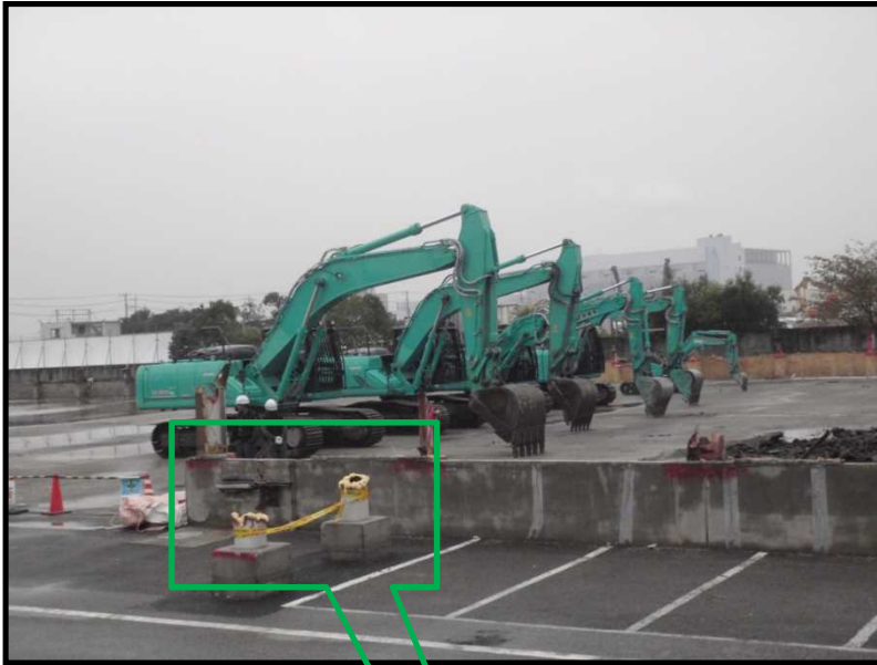
鉄骨造建屋解体状況全景
