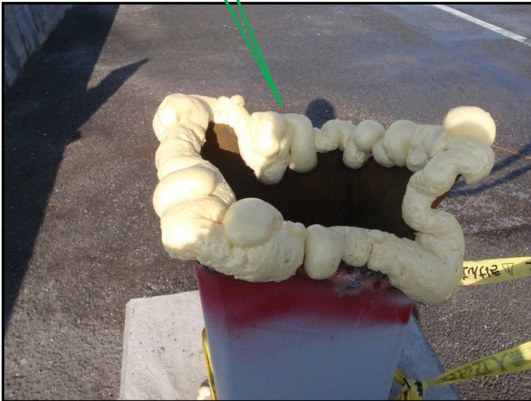
鉄骨柱切断小口養生
