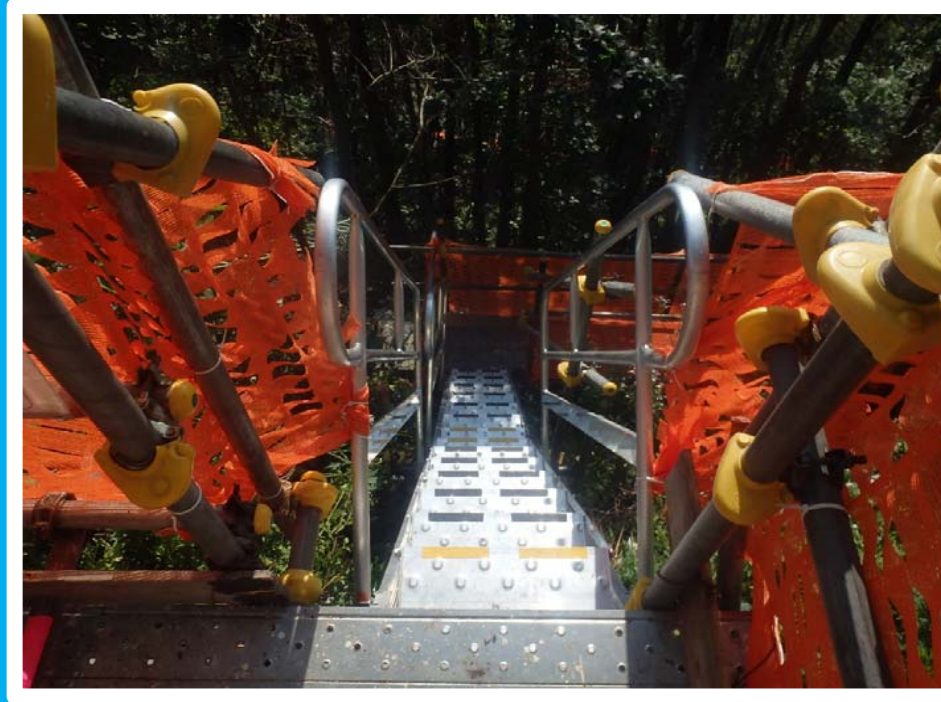
滑り止めテープ貼付
