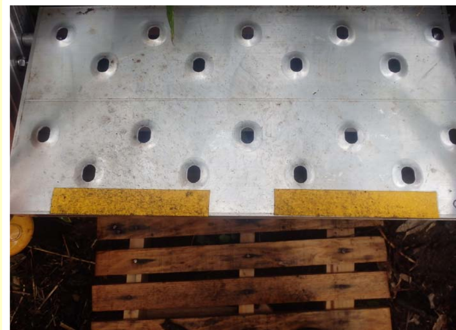
段差変わり部
