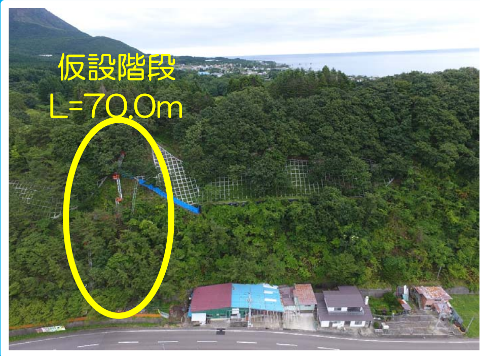
現場全景写真
