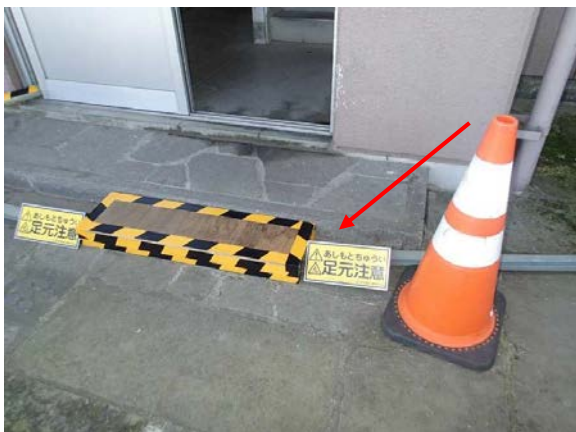
仮設ホース横断部の段差解消対策・注意喚起看板
