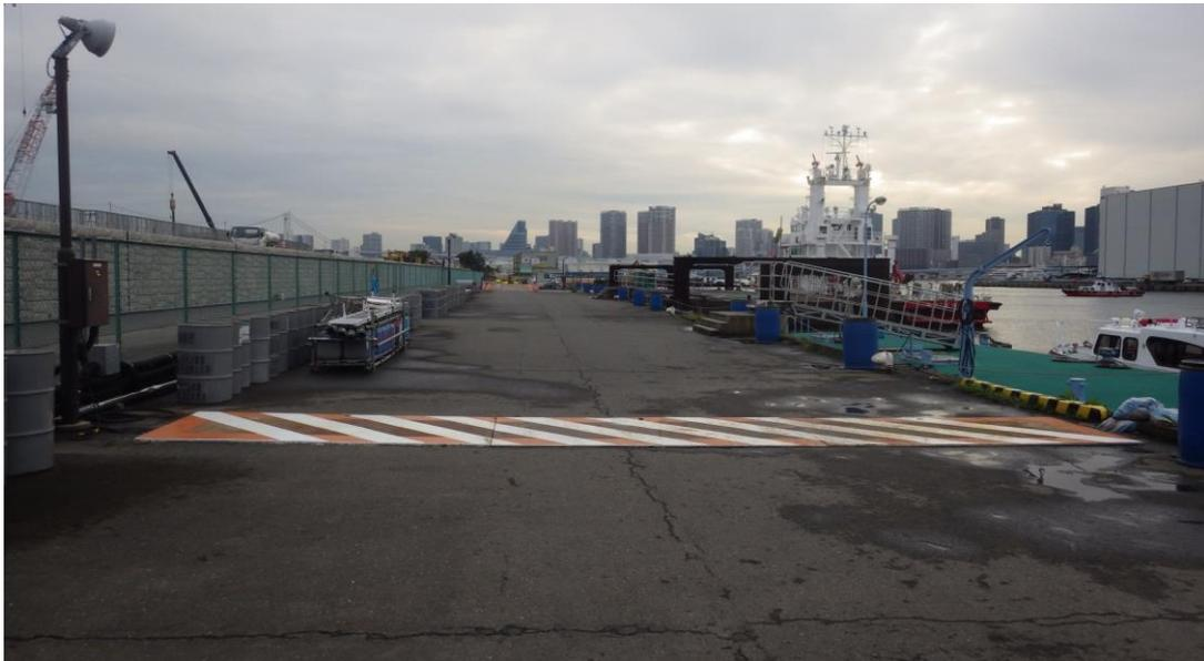
埋設ケーブルを養生している敷鉄板に白ペイントで明示することで、夜間でも認識できるように注意喚起を図っている。
