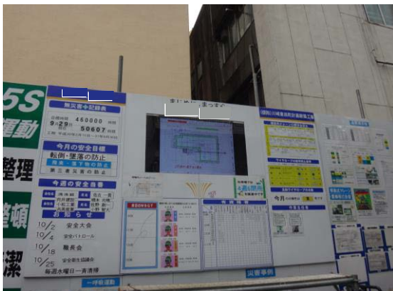
場内危険箇所の掲示
