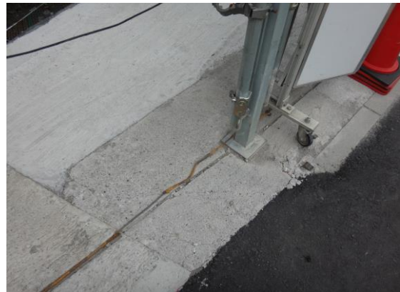
キャスターゲート下のガイドワイヤーを埋もれさせて、つまずき箇所を低減
