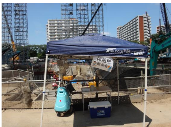
休憩箇所の明確化 ミストファン付の休憩所を3か所に設置
