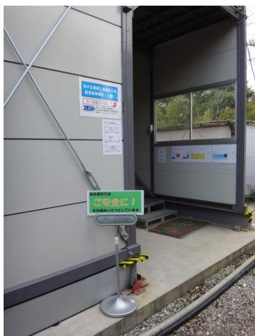
現場入口での音声による呼びかけ 検知器により反応し、「水分・塩分を補給しましょう」「ご安全に」と声掛けをおこなった
