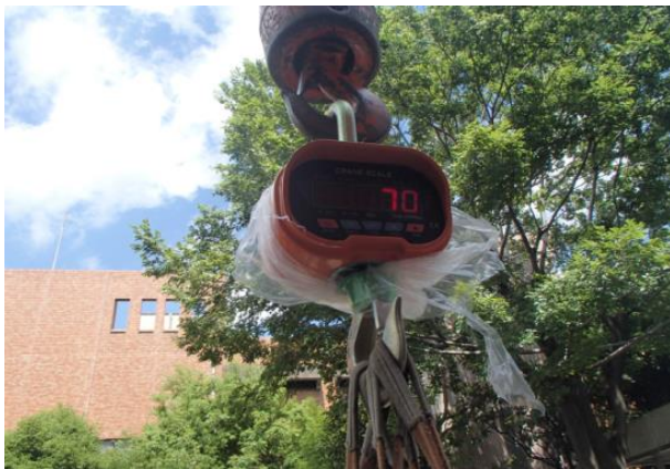
クレーンスケール使用状況①
