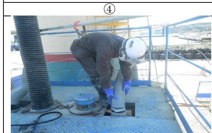
④ エア抜きのホースを外す。 (外す前)
