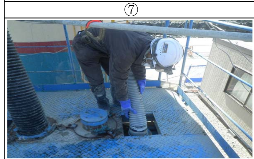
⑦ エア抜きのホースを取り付ける。
