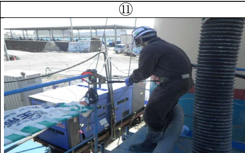
安全帯を使用して安全ブロック使用で下部に下がる。
