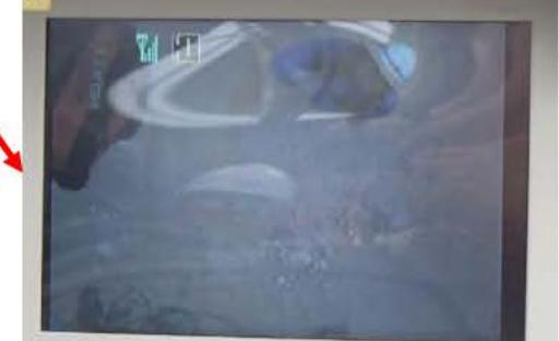
吊荷作業時、クレーン運転手はテレビモニターによる可視化で死角をなくし安全に作業する事ができた。
