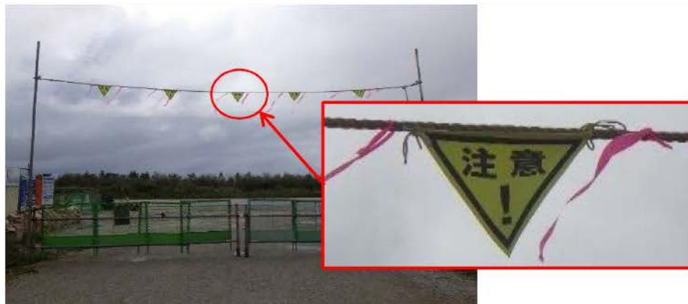
車両高さ制限を設置(3.9m)して搬出車両に見えるように 注意の標識を設置して高さ制限の注意を行った。
