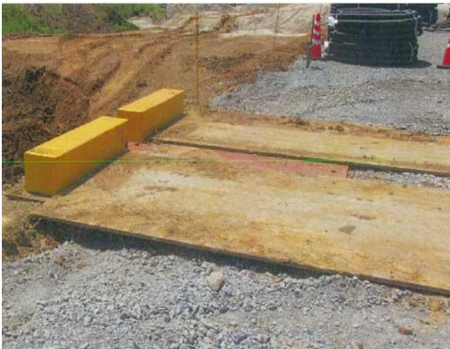
車止めとして敷鉄板に角鋼管を溶接して黄色に塗装して設置しました。
