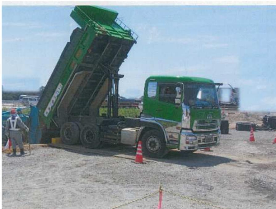
誘導員が後進誘導してダンプアップする場合、合図の遅れ、見落とし等で予定の停止位置からずれが生じますが、目立つ黄色の車止めがあると運転手も確認しながら安全正確に予定位置に停止することが出来ます。
