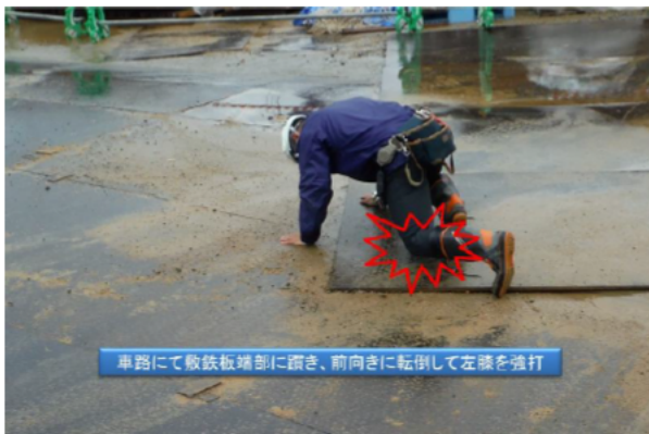
敷鉄板の段差につまずく
