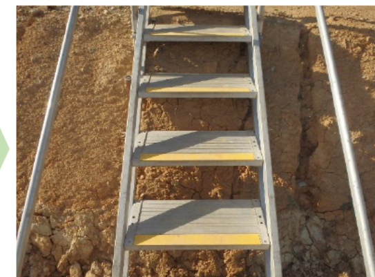
段鼻に黄色テープを貼付してあるので、手摺を持って昇降しましょう
