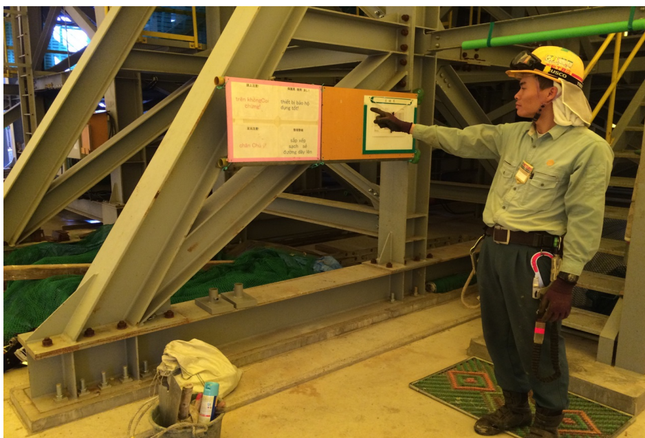
指差し喚呼による安全確認(ベトナム人労働者)
