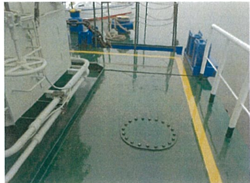
木製甲板を敷き詰め出来ない部分は錆止め再塗装
