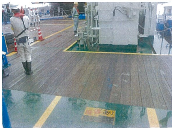
段差部分の「黄色段差あり」表示
