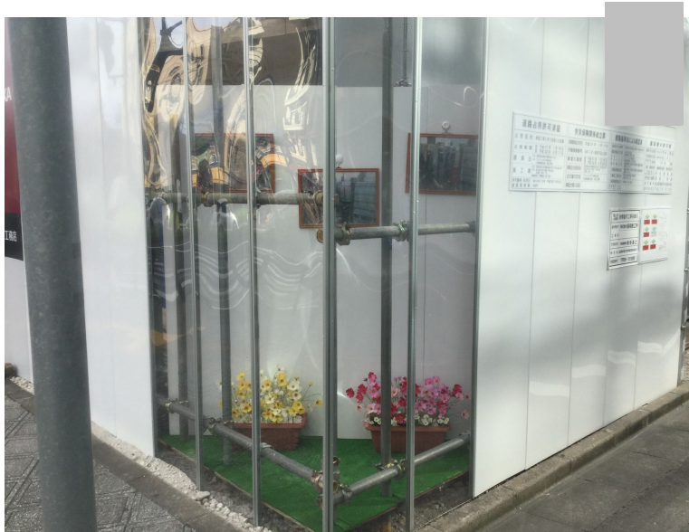
仮囲いでの周辺アピール
