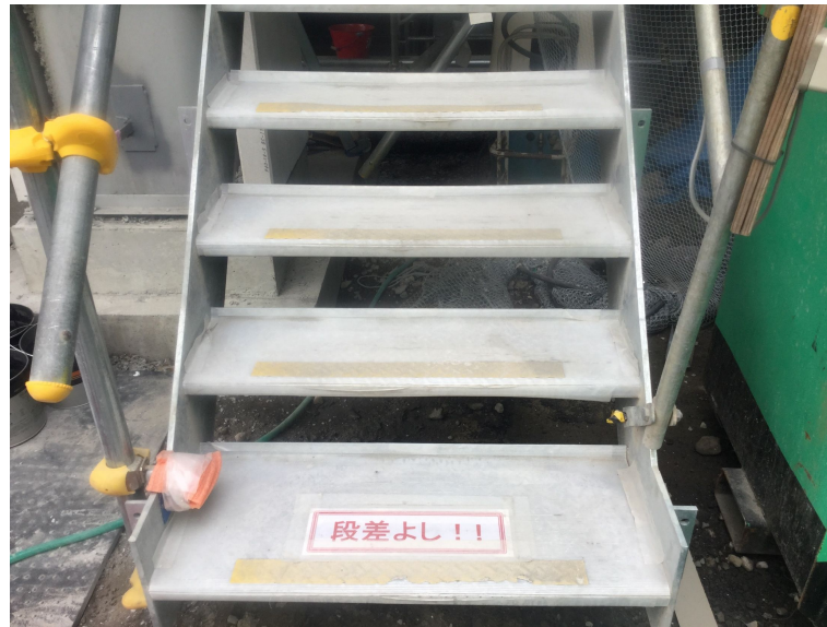
外部階段の養生と段鼻へのノンスリップ取付
