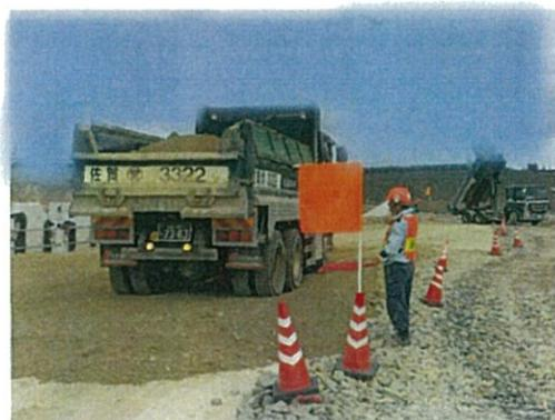
①オレンジの旗と同色のヘルメット着用の誘導員がダンプアップ位置を指示して荷卸し手前3mまで誘導する。
