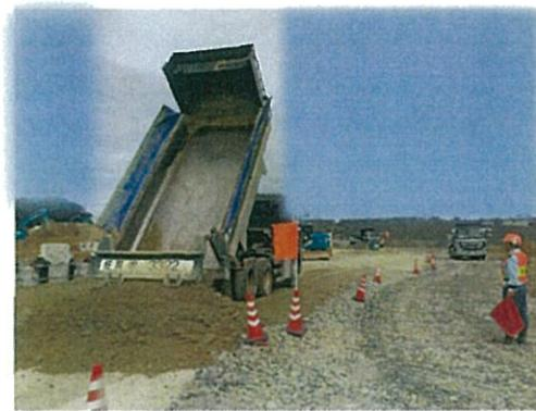
②オレンジの旗はダンプアップ位置に残し誘導員は5m以上離れてダンプアップの終了まで確認してオレンジ色の旗を次のダンプのダンプアップ位置に移動して待機する。
