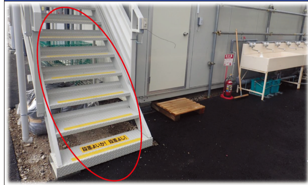
仮設事務所階段にノンスリップテープ貼り
