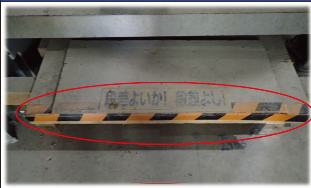
現場内仮設昇降階段にトラテープを表示
