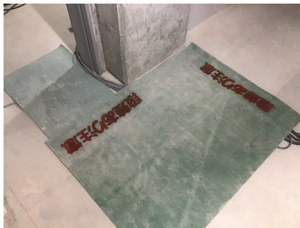
つまずき防止、段差標示
