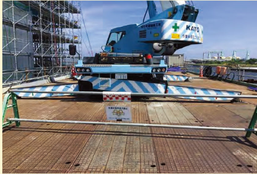
【作業半径内立入禁止】
