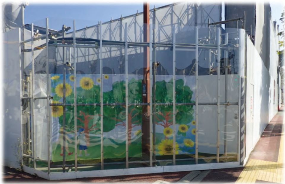
仮囲いコーナー部にデザインシートを設置し注意喚起
