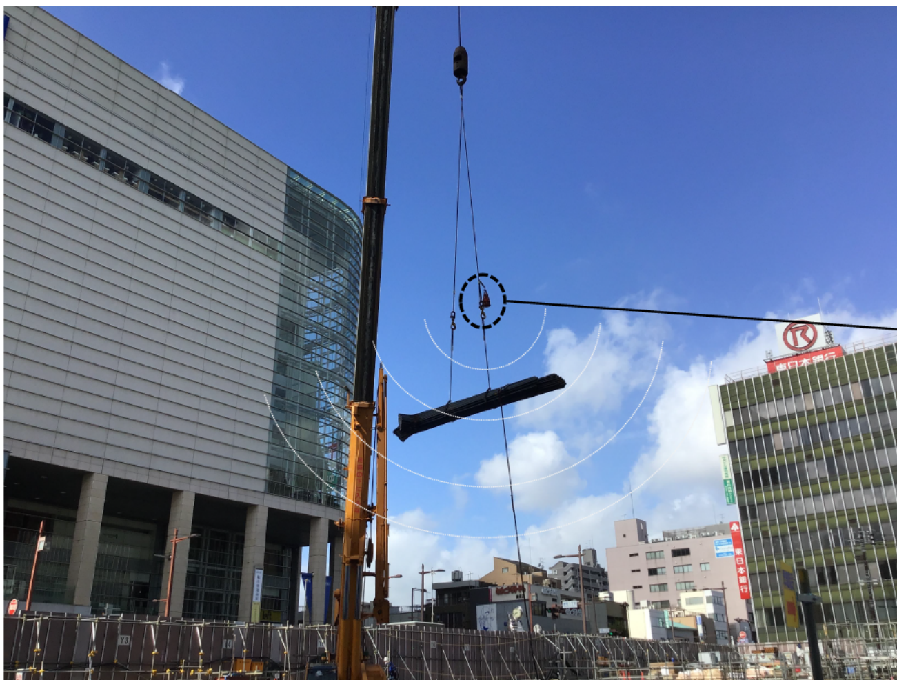
吊荷に警報器を設置
