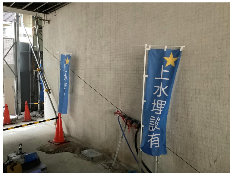
現場設置状況1
