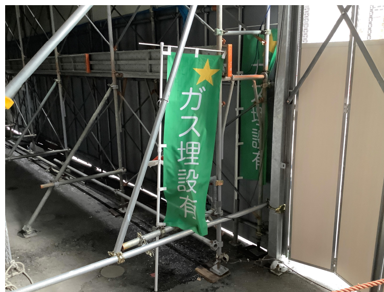
現場設置状況2
