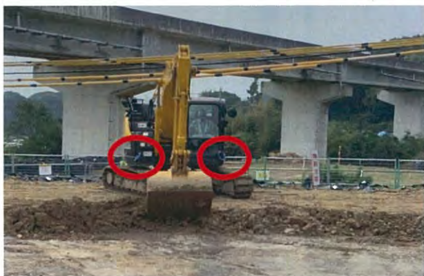
「キャタクリップ」設置状況(作業中)
