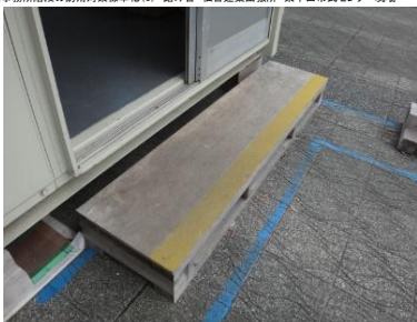
現場事務所階段の防滑対策標準化(5) 緑み台 仙台建築出張所 東中田市民センター現場
