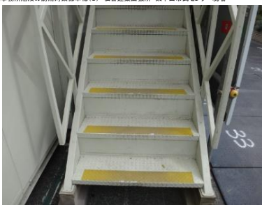
現場事務所階段の防滑対策標準化(4) 仙台建築出張所 東中田市民センター現場
