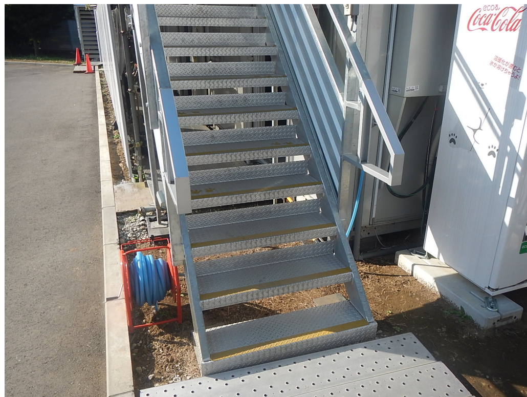
▲仮設事務所階段には段鼻にノンスリップテープを貼り踏面をわかりやすく見える化しています
