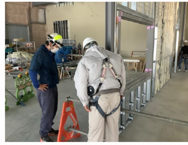
■社員・作業員空調服の着用
