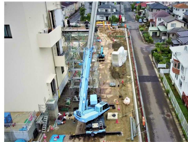
【非常用発電装置搬入状況】
