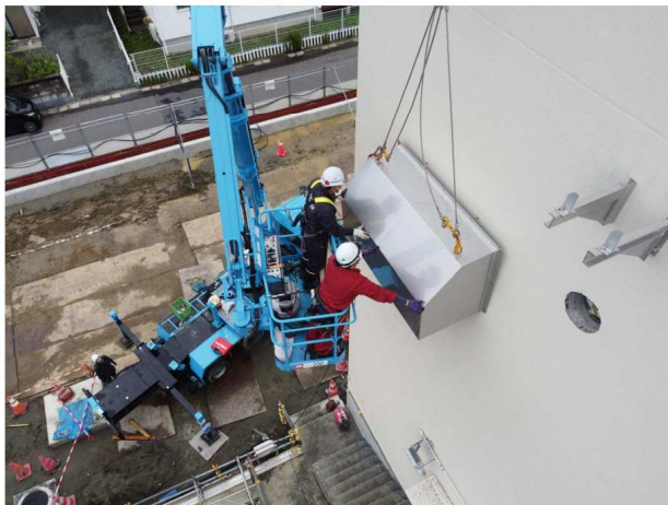
【屋外フード取付 状況】
