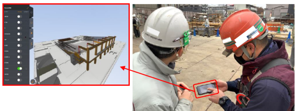
3Dモデルはクラウド上にアップし、 作業員個々がスマートフォン等で都度確認可能
