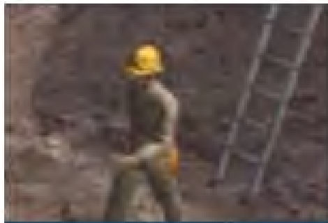
06梯子昇降時に踏み外して墜落
