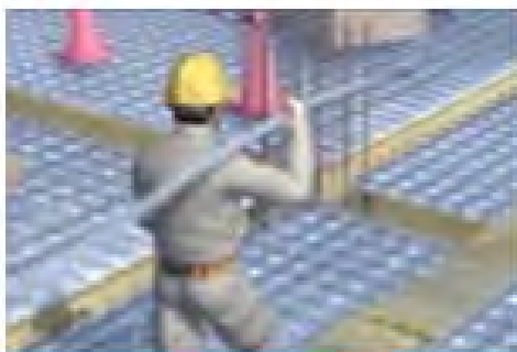
06床配筋につまづいて転倒
